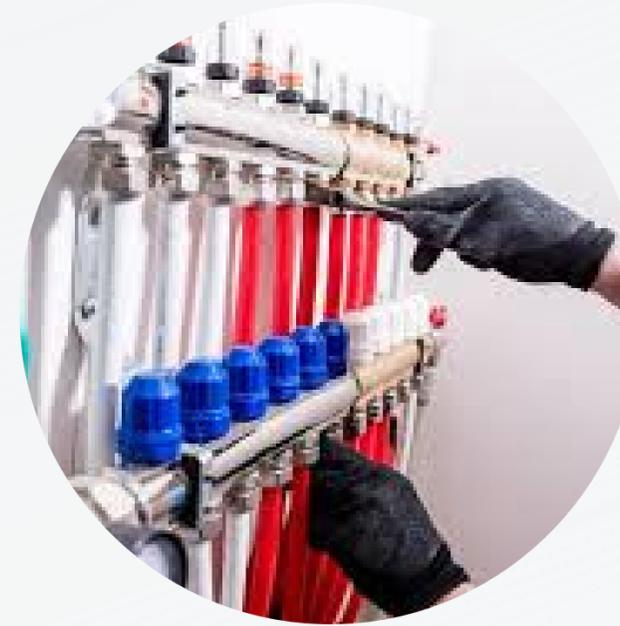
Equilibrage d'un réseau hydraulique
